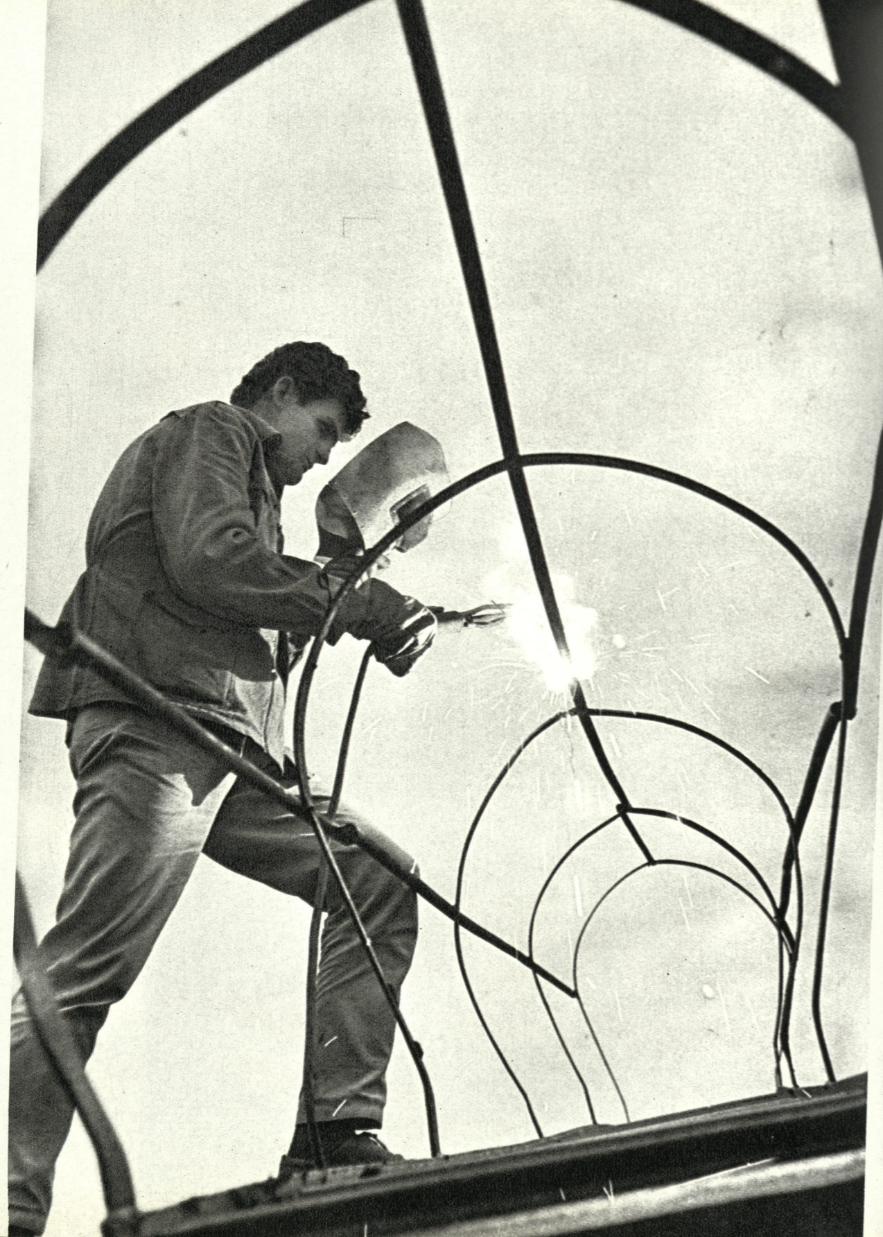
baldojnë të ardhmen e lumtur (Uzina e Përpunimit të thellë të Naftës – Ballsh).
